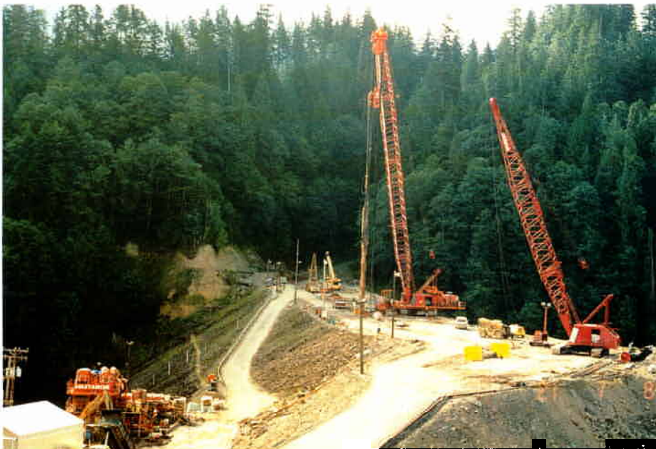
VUE DU BARRAGE DEPUIS LA RIVE DROITE PAREMENT AMONT
