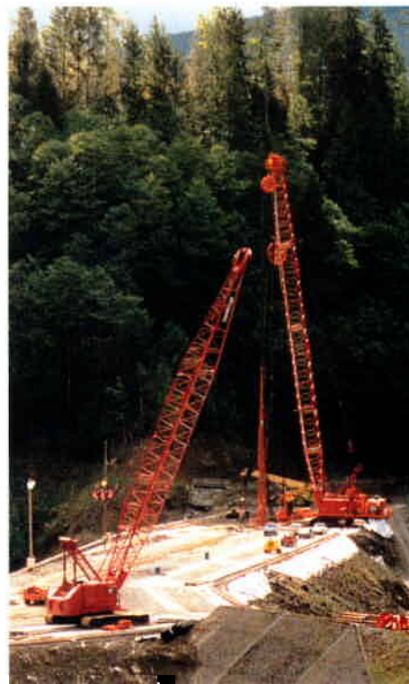
VUE DU BARRAGE DEPUIS LA RIVE DROITE
