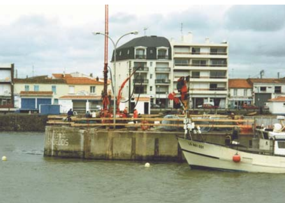
FRANCE - Saint-Gilles-Croix-de-Vie Pier-head reinforcement
