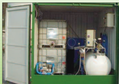
Récupération d'hydrocarbures flottants.
