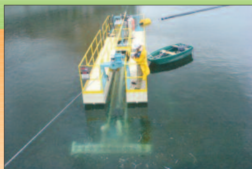
Curage d'un bassin d'eau potable.
