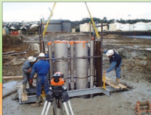
Mise en place d'une porte filtrante.
